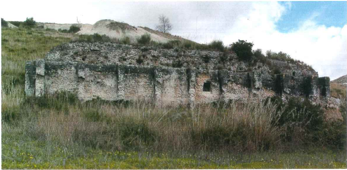
Fig. 19. La grande cisterna a settentrione.
