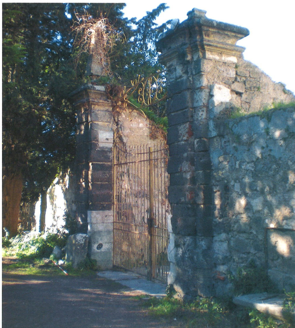
Fig. 83. Sito 64: il cancello d'ingresso alla masseria Puchetti.
