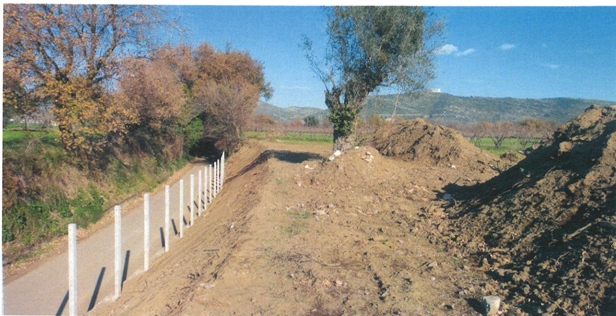
Fig. 56. Bellona, panoramiche del cantiere di scavo da sud.
