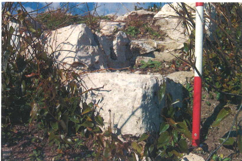
Figg. 20-21. Sito 2. Angolo sud-orientale della torretta; sotto un particolare della struttura muraria.
