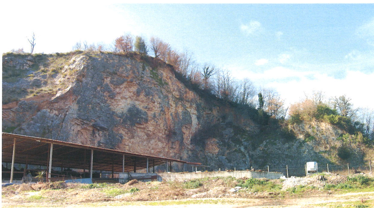
Fig. 45. Veduta generale della cava.
