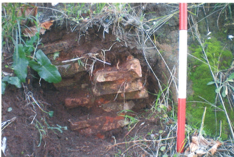
Fig. 79. Particolare della struttura in opera laterizia.
