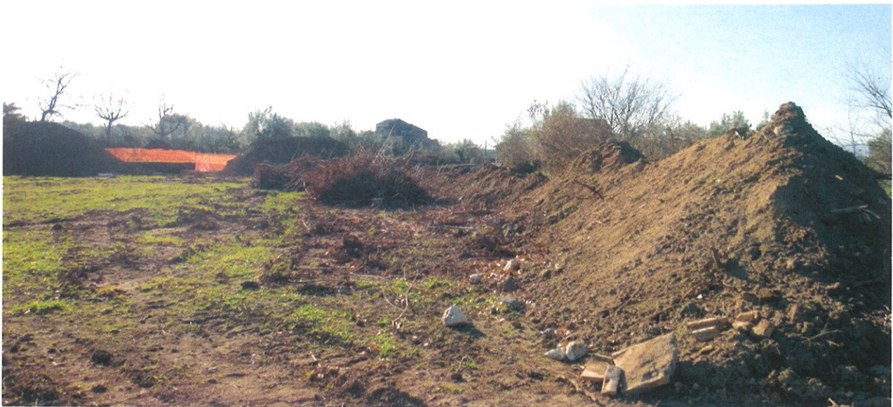
Fig. 55. Bellona, panoramiche del cantiere di scavo da nord.
