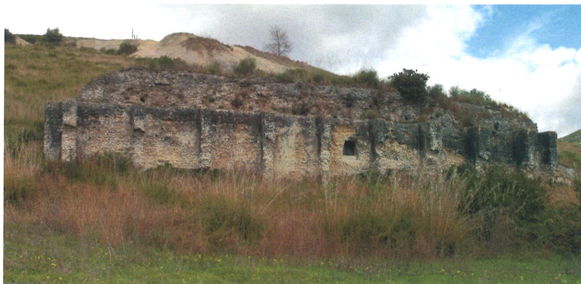
Fig. 23. La grande cisterna a settentrione.
