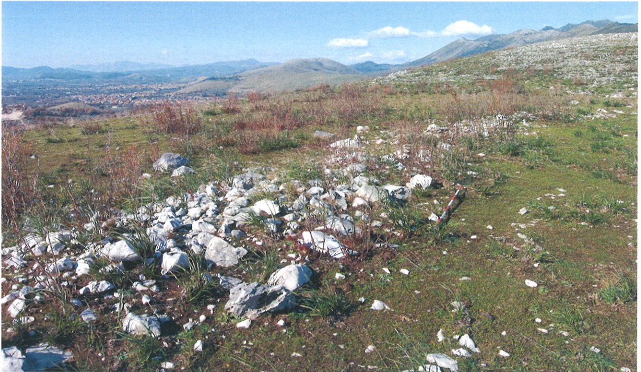
Fig. 93. Sito 72: strutture murarie in pietrame a secco.
