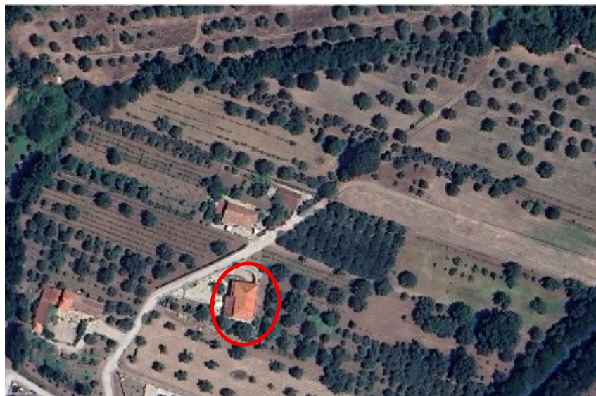
Fig. 3–Ortofoto con indicazione dell’area oggetto d’intervento
